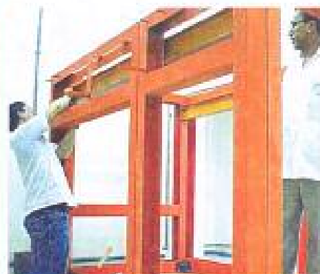
Montagem da estrutura das células do FDG
